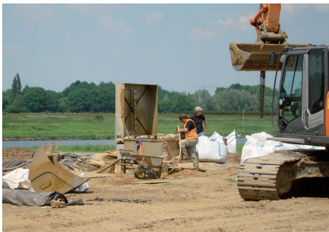
Afb. 2.2 Het zeven van de big bags met behulp van de verbeterde versie van de Lutterzeef.
